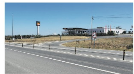
Acesso norte a Entradas pelo IP2 só é possível, de momento, no sentido Castro Verde-Beja. ■ DANIEL BRITO
